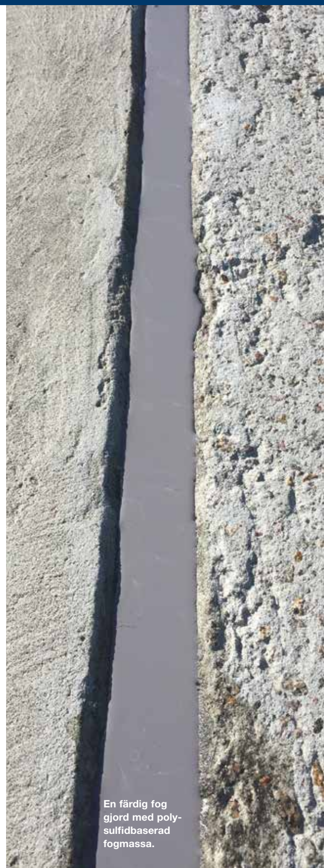
Ett uppdrag som Fogspecialisten genomfört är renovering av en betongläktare på Slottsskogvallen i Göteborg.
